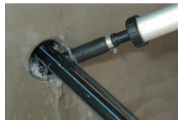
... Kabeldurchführung wird mit ...
